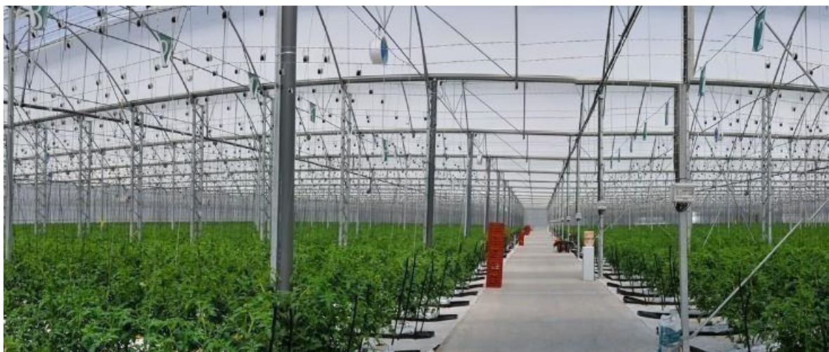
(serre chauffée avec la chaudière à AIR pulsé située à Noordeinde Hollande.)
