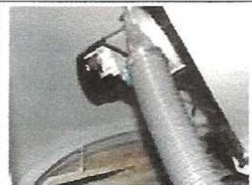
Ouvrir la trappe de révision située sur la partie avant basse de la réserve! Enfiler la gaine de retour d'air sur la turbine et la fixer solidement avec le collier serre-flex. Adapter la longueur de cette gaine et la fixer dans le silo!
