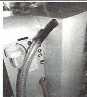
Introduire la gaine de retour d'air dans l'habillage arrière de la chaudière et l'emboîter sur la turbine d'aspiration!
